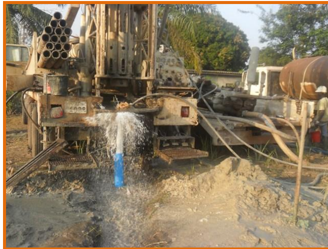
Réalisation d'un forage avec remontée de l'eau
