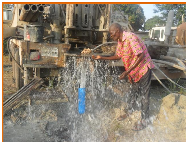
Tubage de la tête de forage
